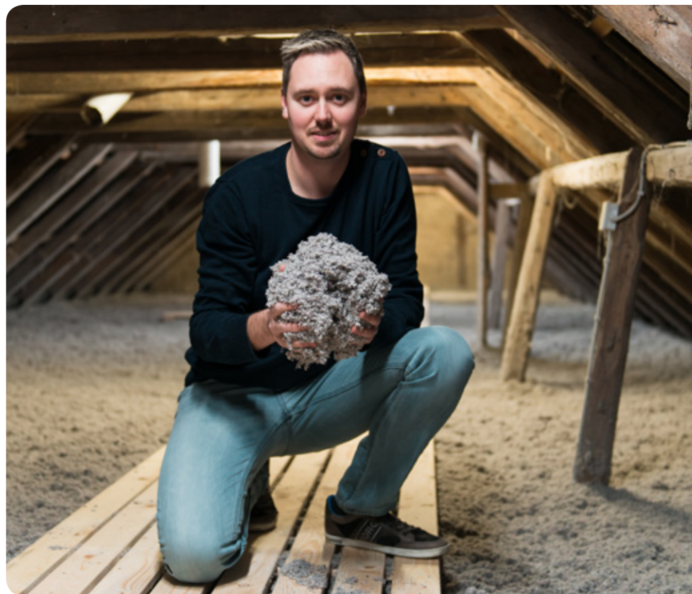
Thomas viser, at han har fået isoleret på loftet. Ingen kradsende glasuld - kun gamle aviser og ugeblade
